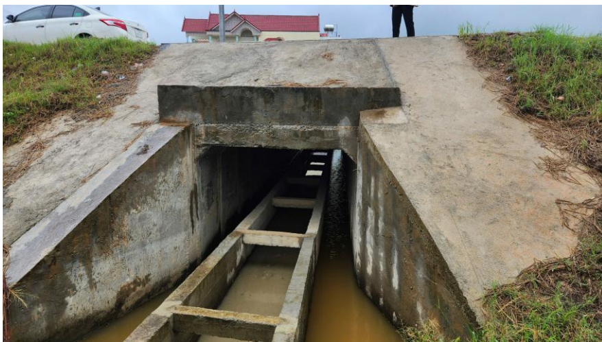
Công và kênh phía Tây
