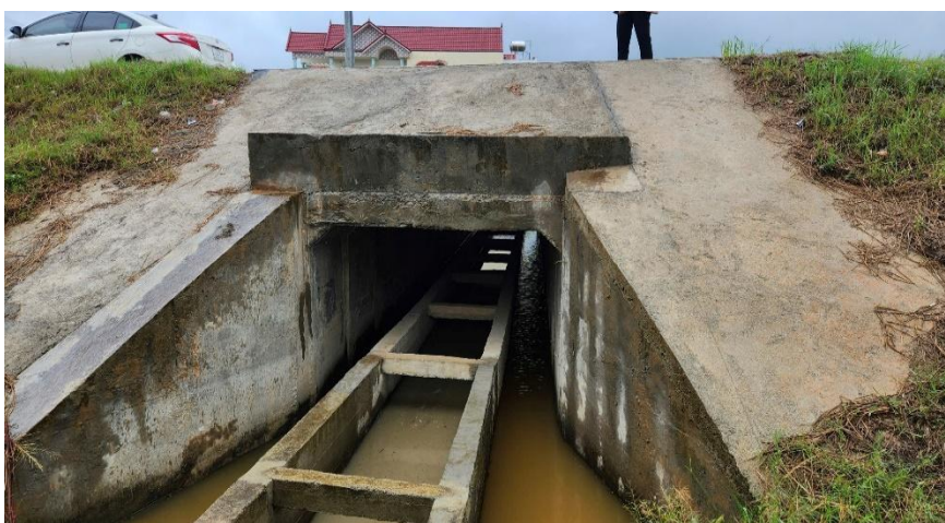
Hiện trạng cống và kênh phía Tây DA
