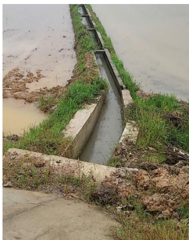
Hiện trạng kênh phía Đông DA
