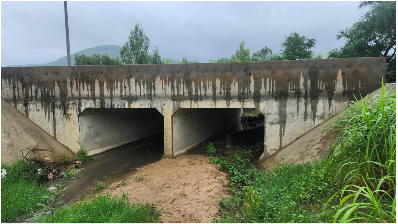
Cống thoát theo suối n(B \times H) = 2(3m \times 2m)
