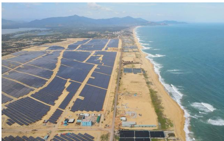
Hình 18: Nhà máy điện mặt trời Phù Mỹ
